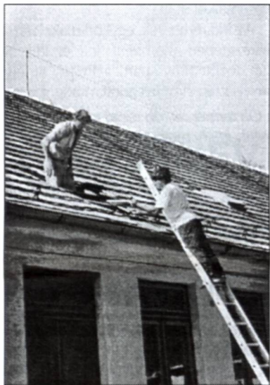
Tetőfelújítás az Aradi utcai óvodában
