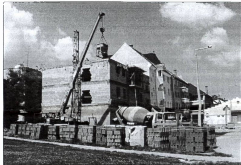
Kossuth utcai építkezések
